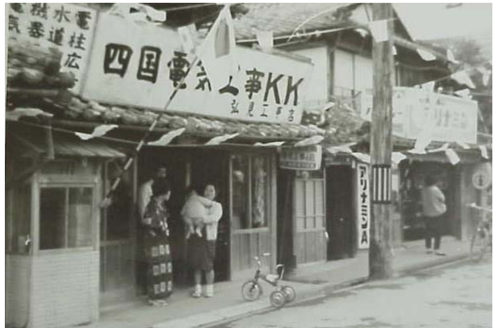
四国電気工事(株)弘見工事所
