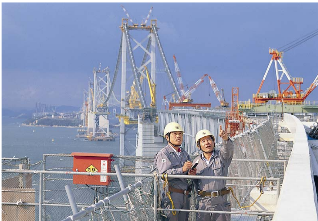
建設中の瀬戸大橋での打合せ
