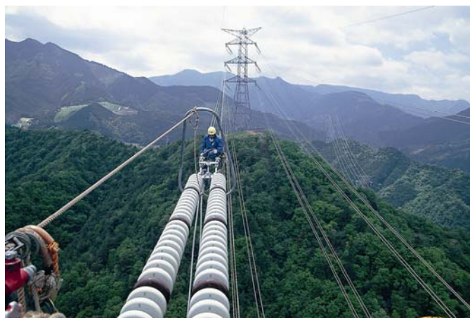
四国中央西幹線架線工事(愛媛県)
