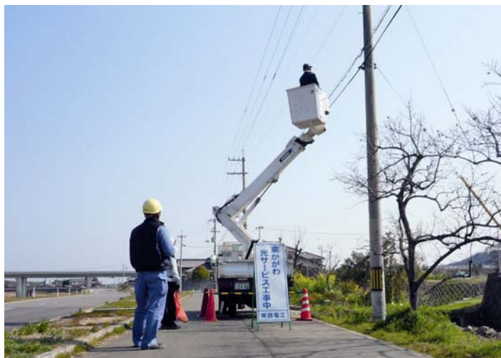
伝送路設備敷設工事
