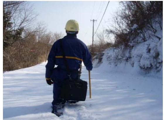
技術課員による配電線巡視
