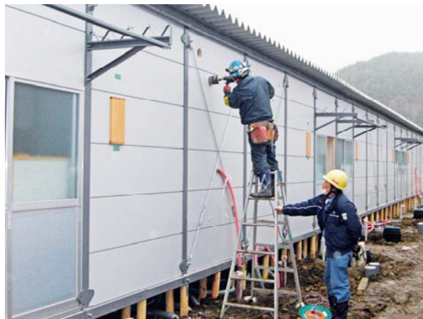
釜石市での仮設住宅の電気設備工事
