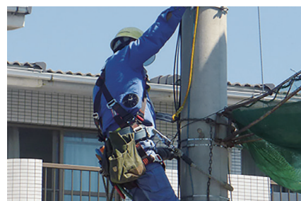
配電現場作業風景(空調服着用)
