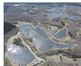
鮫川村青生野(福島県) (太陽光発電所[建設工事])
