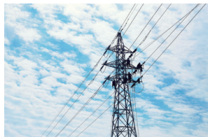
送配電設備工事業の施工事例
