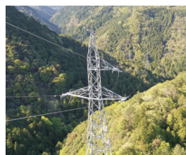
ユラス上勝神山(徳島県) (風力発電所[送電工事])
