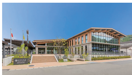
松野町新庁舎(愛媛県) [ZEB物件、CLT工法]
