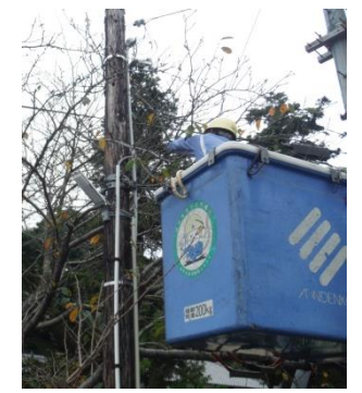
延命寺の屋外灯の樹木伐採
