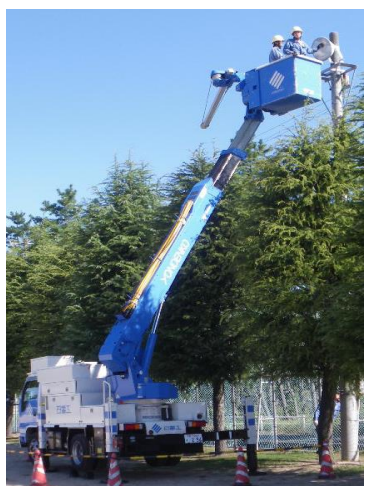
小学校の照明灯の清掃
