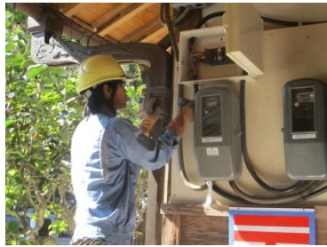
阿南営業所 太龍寺の電気設備点検
