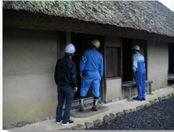
吉野川営業所 重要文化財の電気設備点検
