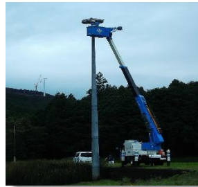
西予営業所 コウノトリ営巣塔の点検
