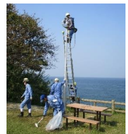
新居浜営業所 黒島海浜公園内の照明清掃
