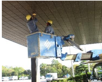
西条営業所 西条運動公園内の照明清掃
