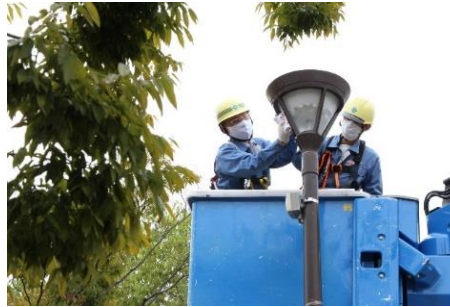
香川支店・高松営業所 高松市立中央公園内の照明清掃
