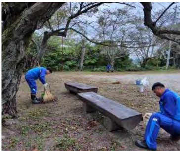
香川支店 白峰公園内のベンチ塗装
