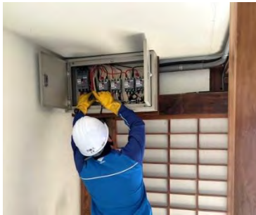
牟岐事業所 薬王寺境内の電気設備点検
