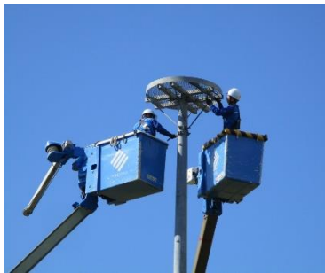
八幡浜営業所 コウノトリ塔点検
