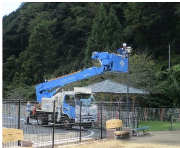
八幡浜営業所 八幡浜市双岩ふれあいパークの 外灯清掃
