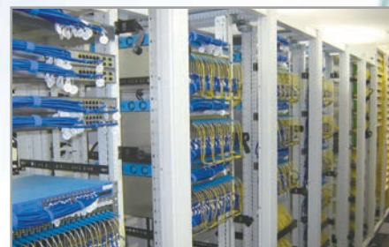
通信機器設置
