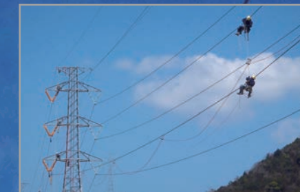
187kV架空送電線 電線張替作業
