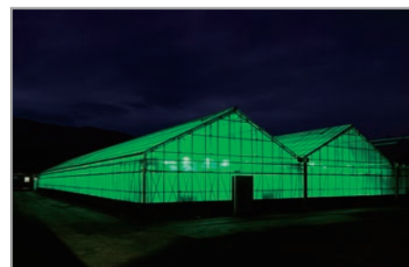
緑色LED点灯時のハウス外観
