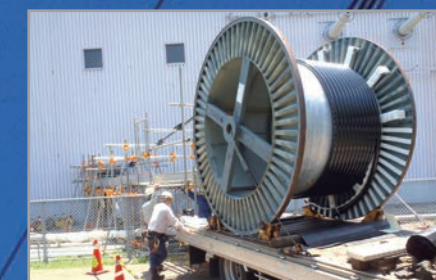
187kV地中送電線 ケーブル張替作業
