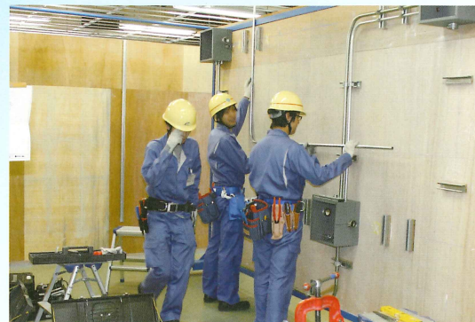
▲一般工事实習室
