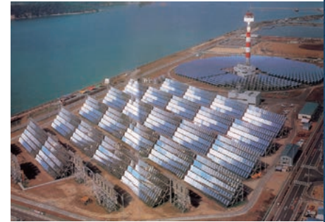
手前が曲面集光方式、奥がタワー集光方式 (発電出力はともに1,000kW)
