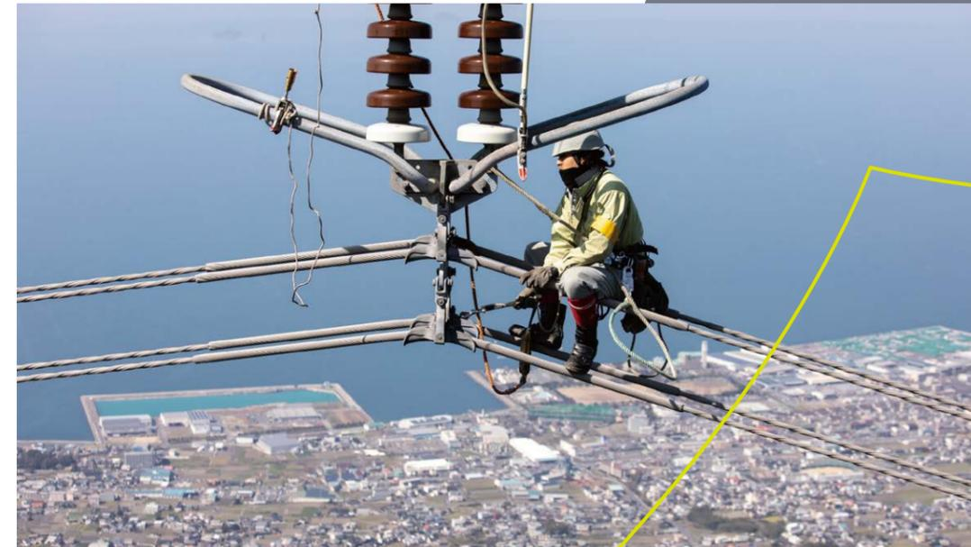
鉄塔と鉄塔の間に電線を張る仕事を「架線工事」といいます。
