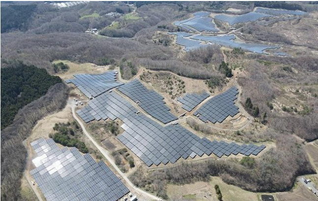
シャープ鮫川村青生野太陽光発電所
