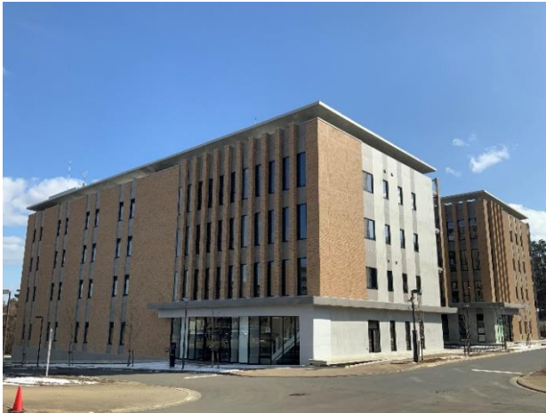
東北大学(青葉山3)新営電気設備工事
