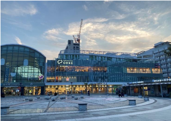
JR四国高松駅ビル(TAKAMATSU ORNE) 新築他工事
