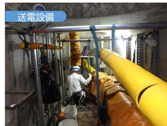
番の州鉄道支線ケーブル(張替・布設・撤去)
