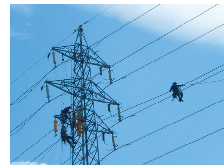
今治線 1 号他送電線張替 愛媛県
