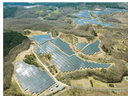
シャープ鮫川村青生野太陽光発電所電気工事 福島県
