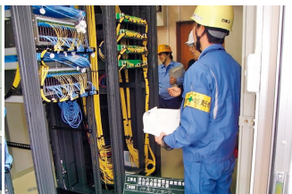
情報通信工事の施工体制整備
