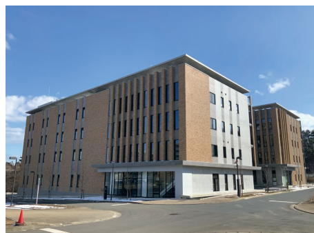
東北大学(青葉山3)新館電気設備工事 宮城県
