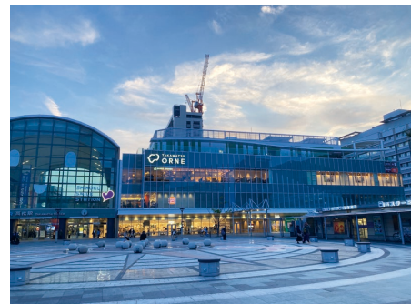
JR 四国高松駅ビル (TAKAMATSU ORNE) 香川県
