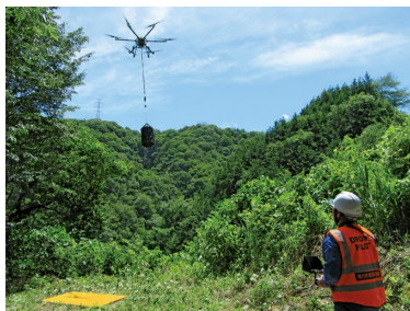
ドローンによる資機材の運搬作業
