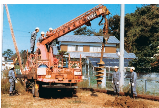
工事現場の機械化
