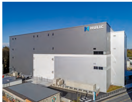
ヒューリックロジスティクス野田Ⅱ 千葉県
