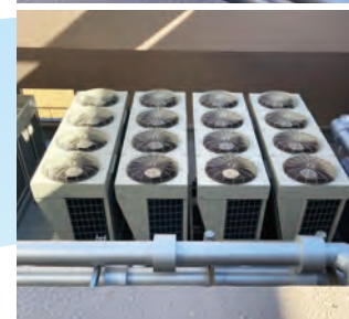
JA 高知病院（高知県） 高効率空調システムへの更新 [CO 2 削減事業]
