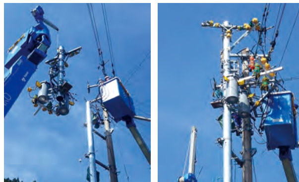
プレハブ工法による施工風景
