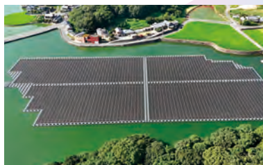
二ツ池太陽光発電所（香川県）
