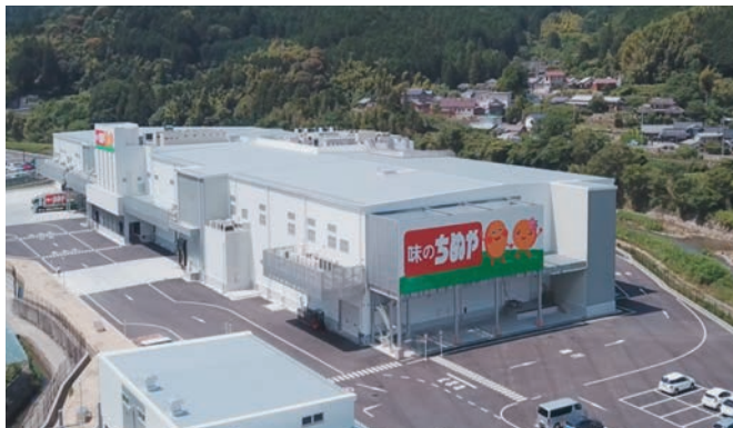
㈱ちゆがホールディングス 四国工場新築工事 〔愛媛県〕（電気、空調・給排水設備）
