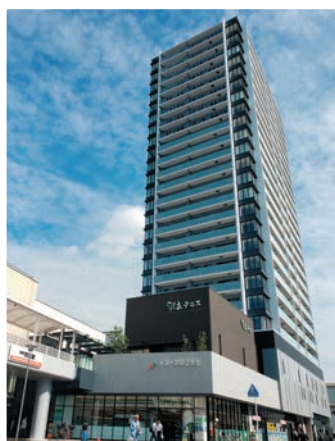
羽衣駅前地区第一種市街地再開発事業 新築工事〔大阪府〕（電気設備）
