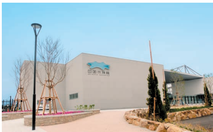
四国水族館新築工事〔香川県〕（電気、空調・給排水設備）
