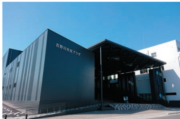
吉野川市民プラザ建設工事 〔徳島県〕（電気、空調・給排水設備）
