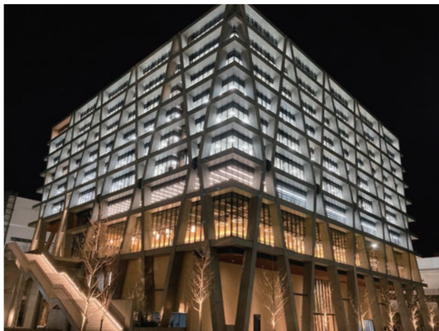
大阪大学外国学研究講義棟 [大阪府] (電気設備)
