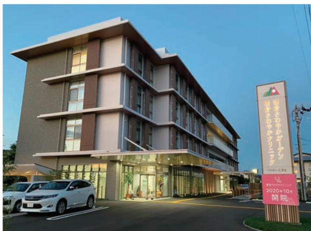
朝倉さわやかガーデン、朝倉さわやかクリニック [高知県] (電気、空調・給排水設備)
