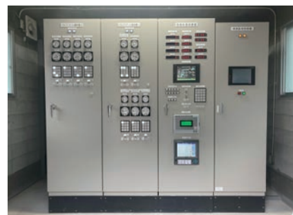
銅山川第2電気設備改修工事 [愛媛県] (電気計装工事、制御盤設計・製作・施工)
