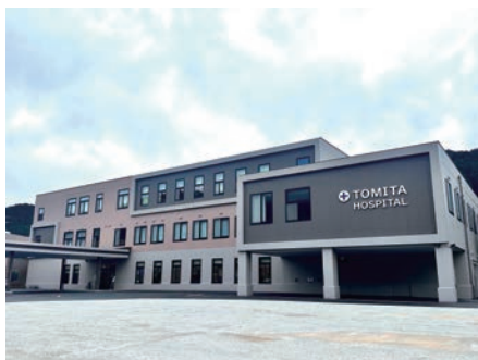
(上) 富田病院東棟増築工事 [徳島県] (電気・機械設備工事)
