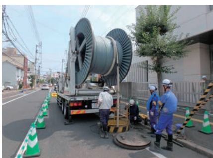
西通線4Lケーブル張替 [香川県] (地中ケーブル工事)
