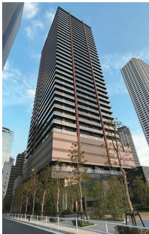
西新宿五丁目北地区防災街区整備事業 施設建築物新築工事 [東京都新宿区] (電気設備工事)
