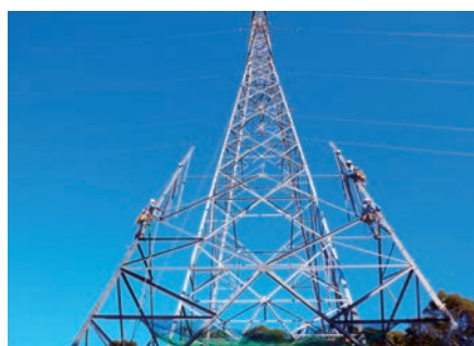
新改高知線4建替 [高知県] (鉄塔組立工事)
