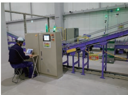
物流センター [香川県] (搬送システム設計・施工)
