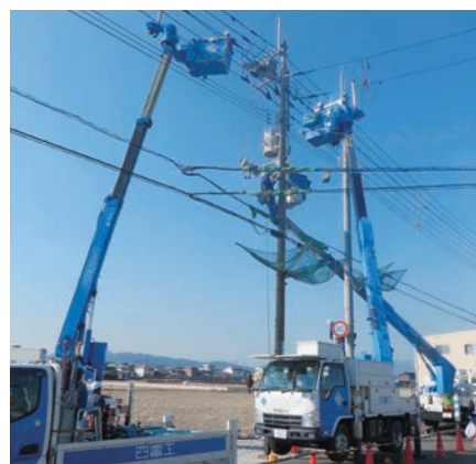
電柱支障移設 [徳島県] (配電工事)
