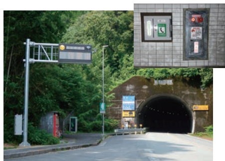
令和2年度松尾トンネル外非常用設備 更新工事 [愛媛県]
