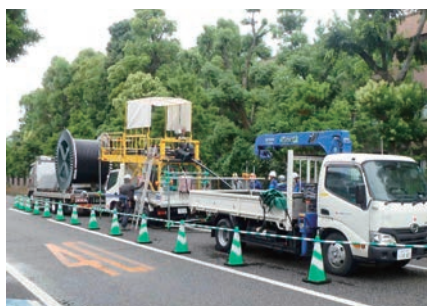
西通線3Lケーブル張替 [香川県] (地中ケーブル工事)
