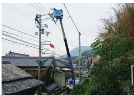
停電作業 [愛媛県] (電線張替工事)
