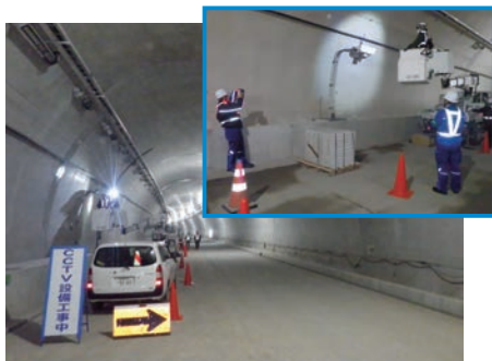
松山自動車道 伊予IC～内子五十崎IC間 CCTV設備工事 [愛媛県]
