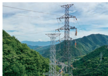
大洲南幹線79他建替 [愛媛県] (鉄塔建替工事)
