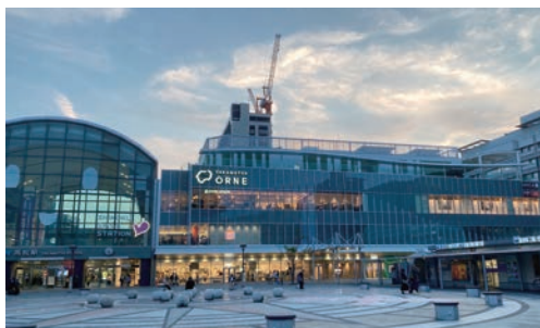
JR四国高松駅ビル新築他工事 [香川県] (空調・管工事)
