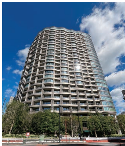
パークコート神宮北参道 ザタワー新築工事 [東京都] (電気設備工事)
