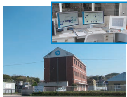
琴平町五条浄水場外8施設電気設備更新工事 [香川県]
