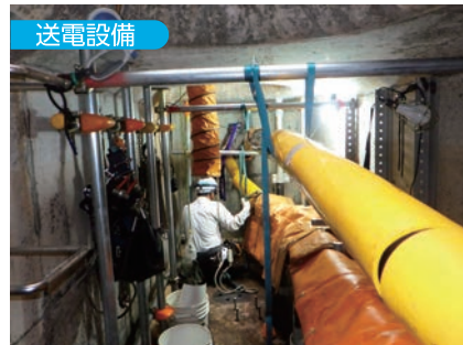
番の州鉄道支線ケーブル（張替・布設・撤去） 香川県 送電・土木
