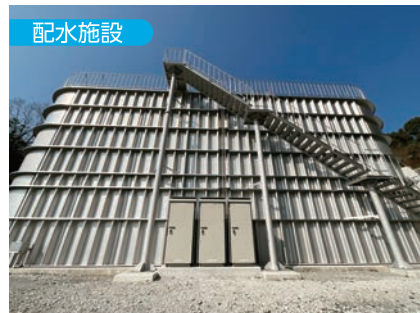
八幡浜市愛宕第4配水池電気計装設備 愛媛県 電気・計装
