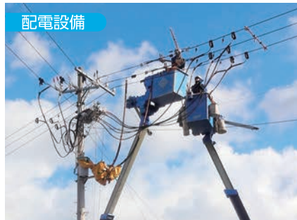
間接活線作業 香川県 配電
