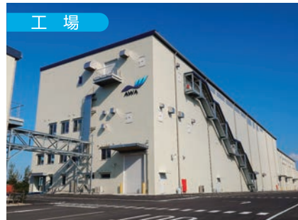
阿波製紙㈱小松島工場 徳島県 電気・計装 空調・管
