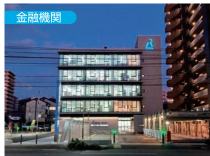
四国ろうきん松山ビル 愛媛県 電気・計装 空調・管
