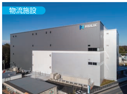
ヒューリックロジスティクス野田Ⅱ 千葉県 電気・計装
