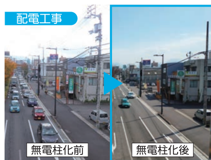
国道33号東石井地区無電柱化工事 愛媛県 配電工事
