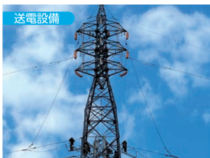
栗林線54他建替 (JV) 香川県 送電・土木
