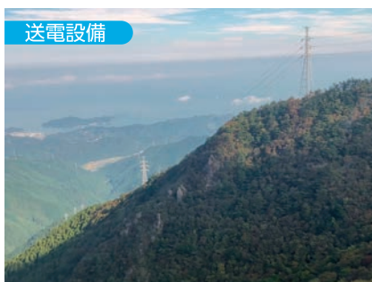
本川線17他OPGW張替 愛媛県 送電・土木
