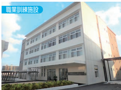
香川職業能力開発促進センター 香川県 電気・計装 空調・管
